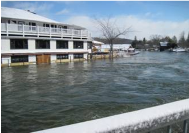
Photo prise entre le 5 et 9 avril 2014 montrant les eaux de la rivière Massawippi au niveau du premier étage du Pub Pilsen.
